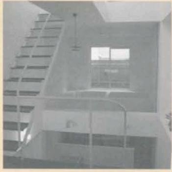
中2階の居間から東側を見る。中2階は、もとの3階にあたる部分である。その床の2/3を撤去し、吹き抜けとしている。
